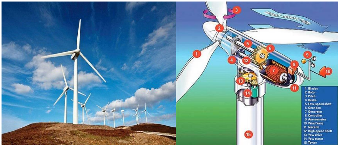
1-rasm. Shamol elektr stansiyasi.
